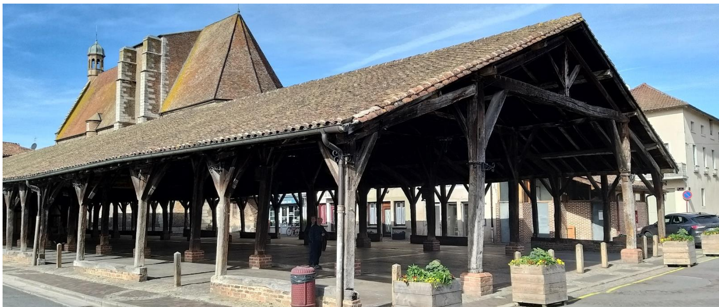
Halles du XV ème siècle de la cité médiévale de Châtillon-sur-Chalaronne (charpente et piliers en chêne).
