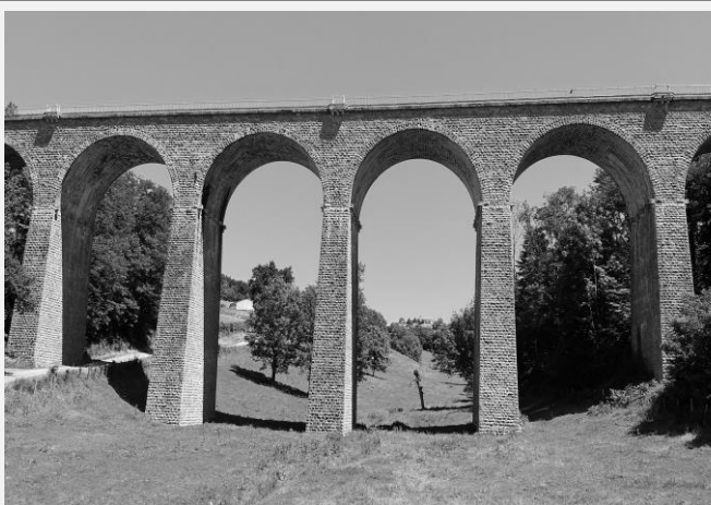
Viaduc de Mussy-sous-Dun (71) - XIX ème siècle-1895.
